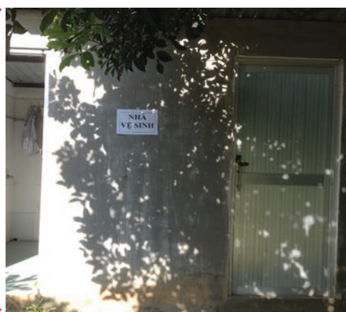
Hình 11. Nhà vệ sinh tự hoại
